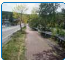
白樺湖(諏訪白樺湖小諸線) 立科町 H28~H31 歩道の高機能化(ゴムチップ)
