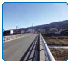
木落し坂(弘沢茅野線) 茅野市 H24~H33 歩道新設
